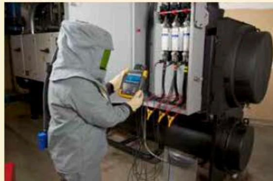
Просто подключите провода для измерения напряжения и гибкие токоизмерительные датчики к источнику электропитания двигателя.
